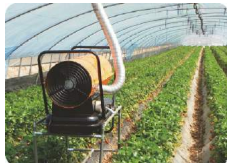
Nagrzewnica pracująca w szklarni
